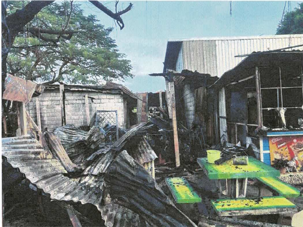
ภาพถ่ายบ้านนักเรียนประสบอัคคีภัย จำนวน ๓ ราย ซึ่งเป็นนักเรียนของโรงเรียนวัดรังสิต สังกัดสำนักงานเขตพื้นที่การศึกษาประถมศึกษาปทุมธานี เขต ๑
